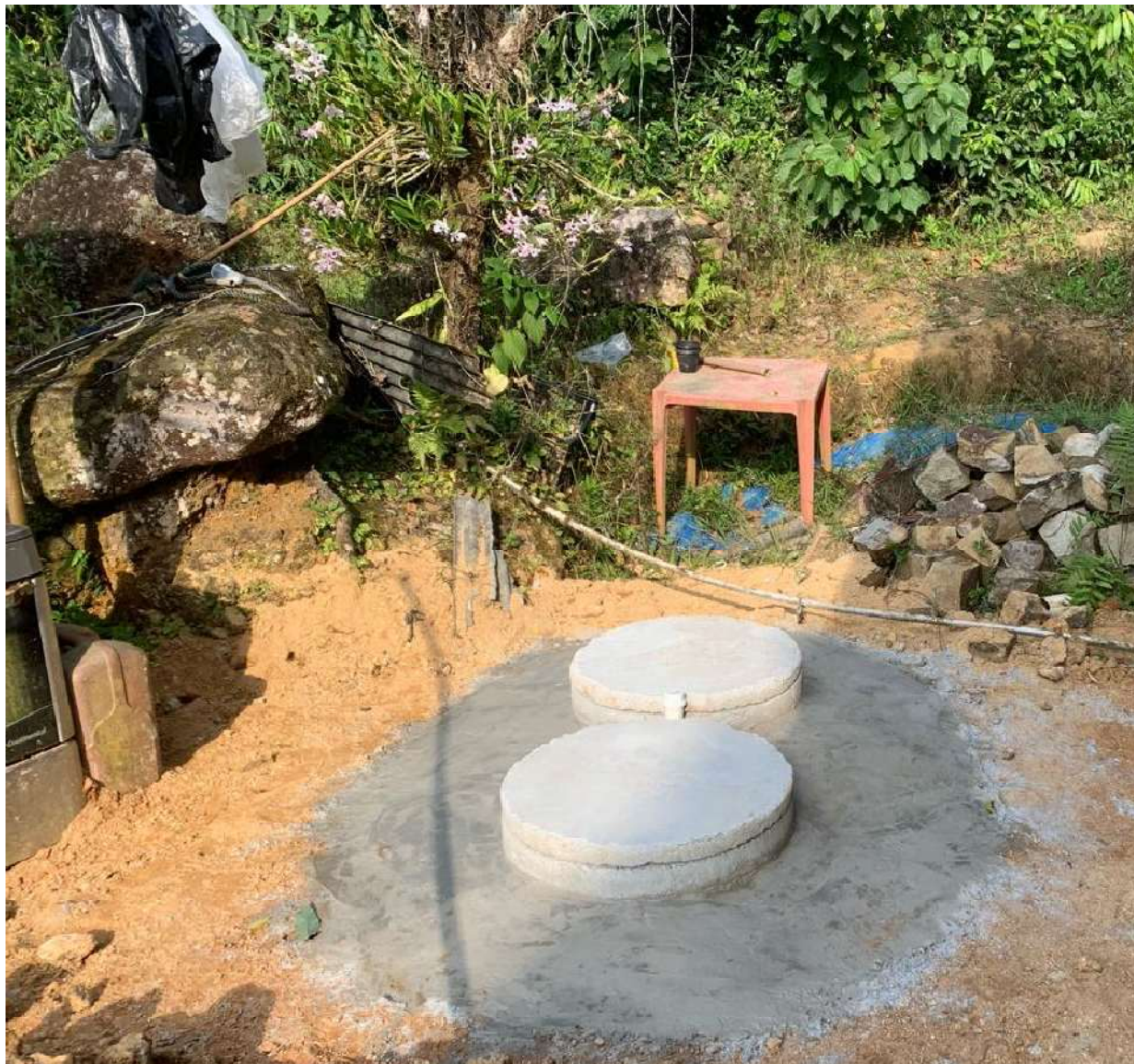
Foto 6. Soluções são instaladas sem custos aos moradores
