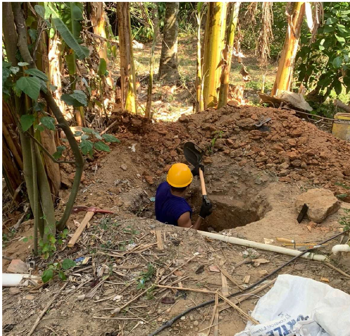
Foto 13. Obras do Sanear Guandu II em Apopal, localidade do município de Miguel Pereira/RJ
