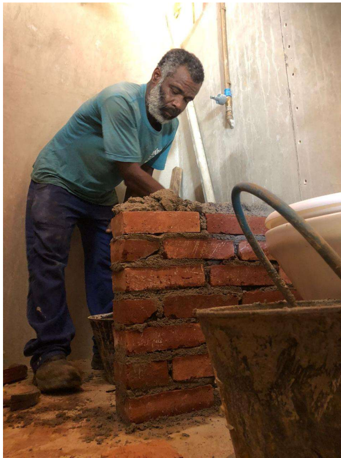
Foto 4. Os banheiro e o sistema de esgotamento já estão em construção.
