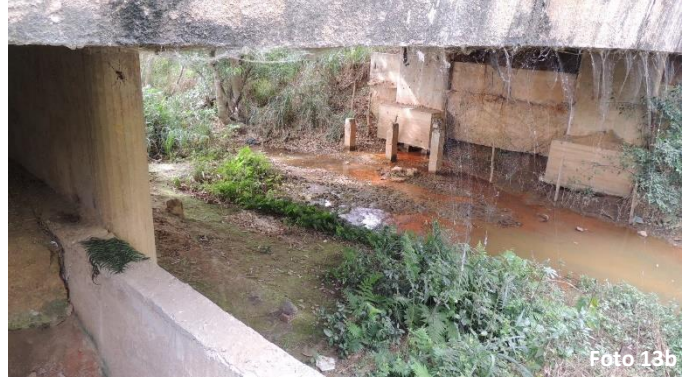
Canal assoreado e com fluxo reduzido
