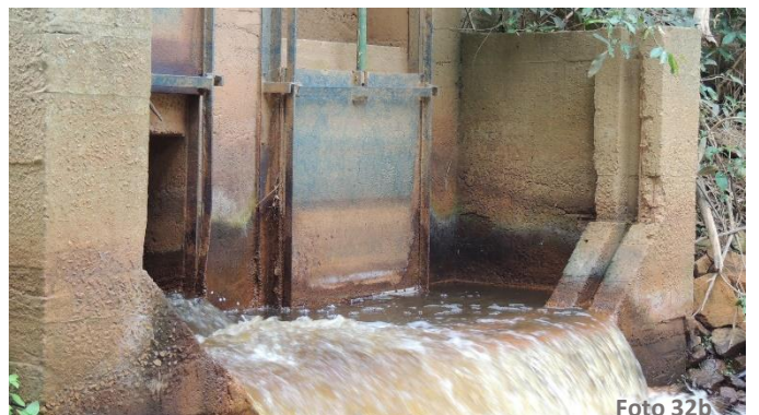
Lado de adução da comporta, devido a comporta aberta a água estava saindo do canal e retornando para o rio Paraíba do Sul
