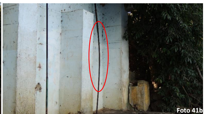
Estruturas de abertura e fechamento das comportas vandalizadas
