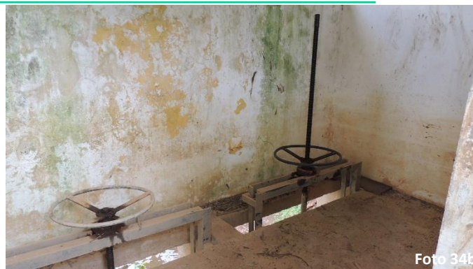
Parte interna com comporta do lado esquerdo aberta
