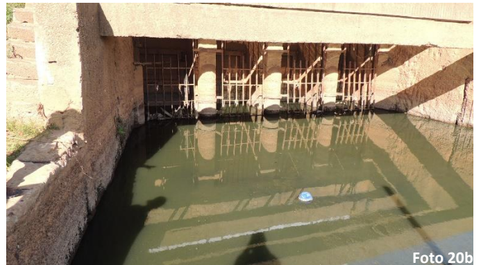
Lado de adução da comporta e parte onde pode ser observado a entrada de esgoto retornando do canal
