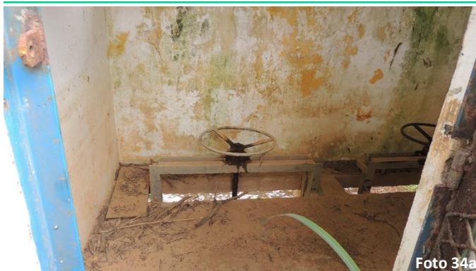
Parte interna com comporta do lado esquerdo aberta
