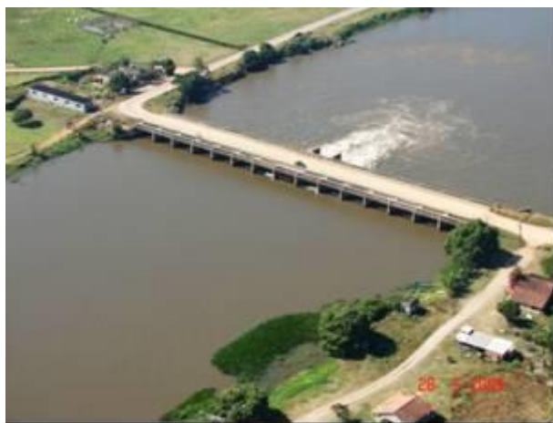
Foto 5.4.2.1 - Vista aérea da Barragem Engenheiro Correia Lima, onde está instalada a bateria de comportas reguladoras de nível do canal das Flechas e lagoa Feia. Necessidade de reforma estrutural e mecânica.
