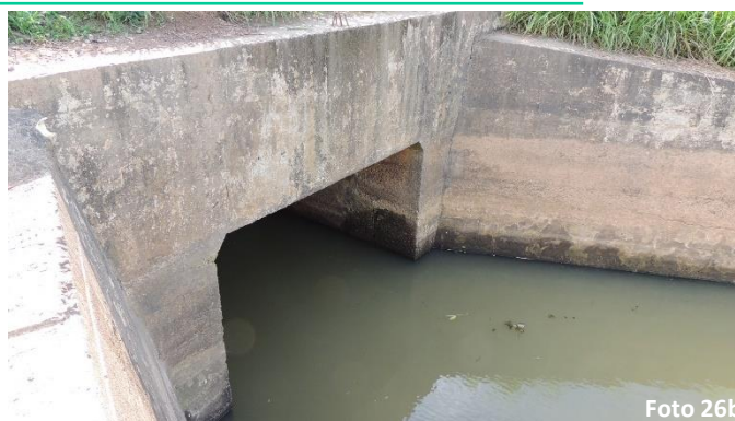
Trecho inicial do canal com assoreamento
