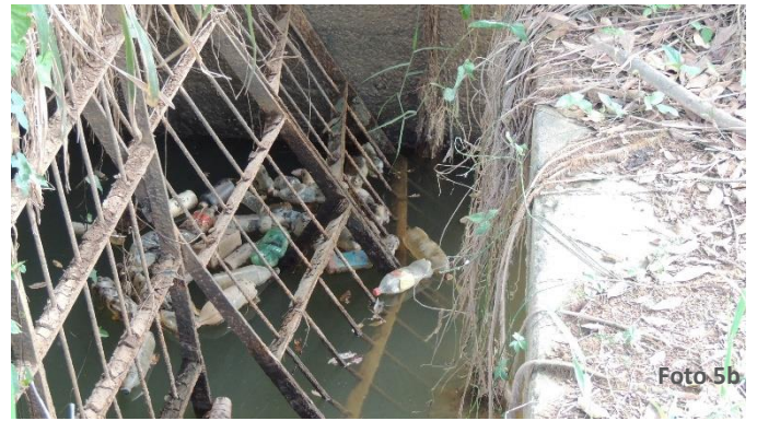
Grade de proteção contra entrada de macrófitas danificada para acesso por terceiros ao interior da comporta
