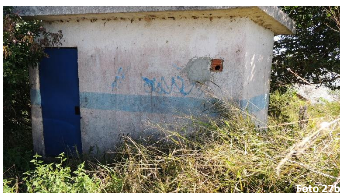
Área externa e interna da comporta, pode ser observado (destaque vermelho) a quebra da alvenaria para vandalismo da comporta
