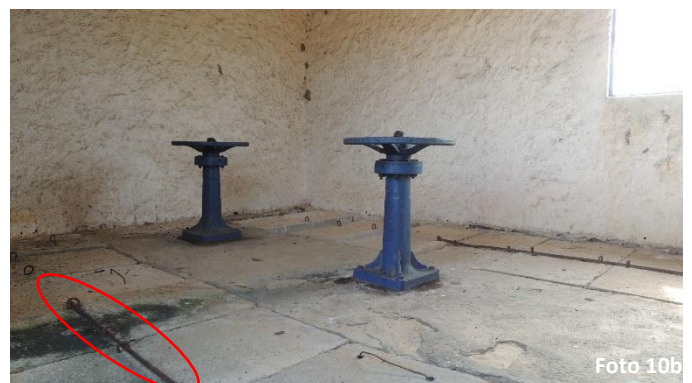
Entrada com cadeado na parte interior para evitar vandalismo. Pode ser observado na marcação em vermelho, vergalhões adicionados sobre o acesso interno da comporta.
