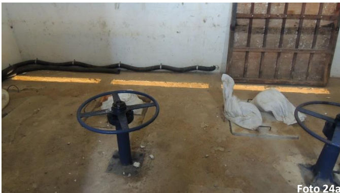
Parte interna da comporta com sacos de areia para dificultar o acesso pela parte inferior da comporta
