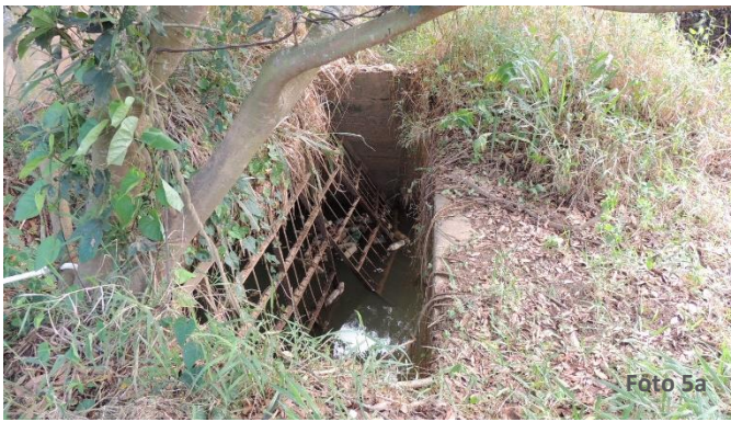
Grade de proteção contra entrada de macrófitas danificada para acesso por terceiros ao interior da comporta
