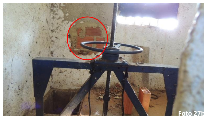
Área externa e interna da comporta, pode ser observado (destaque vermelho) a quebra da alvenaria para vandalismo da comporta
