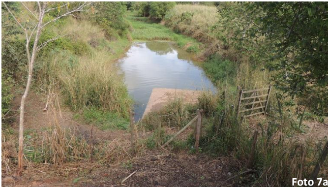
Parte da comporta para o canal Itereré, visivelmente obstruído por vegetação e assoreamento
