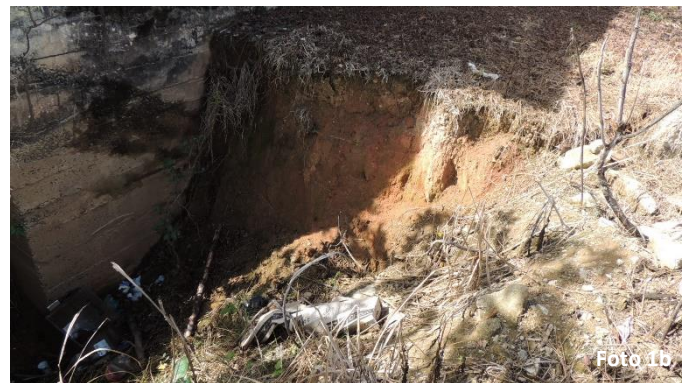
Estrutura externa da comporta e solo cedendo em frente a estrutura da comporta
