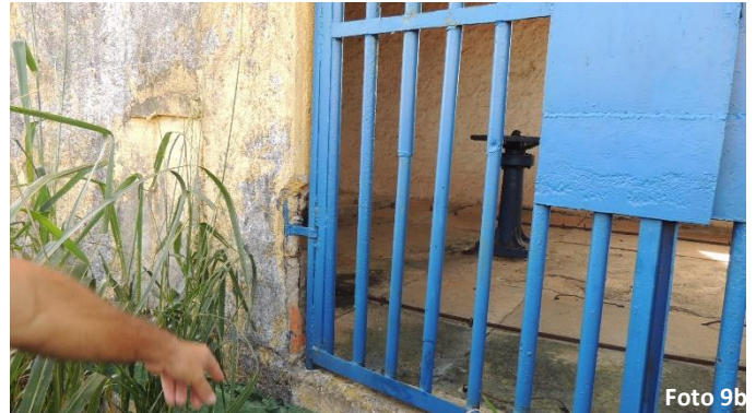
Entrada da comporta com capim alto e estrutura de fixação precisando de reparos
