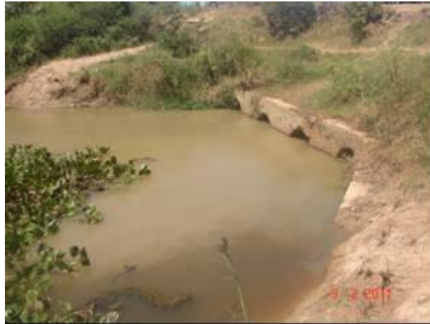
Foto 5.2.2.4 - Vista da ala de adução e suas galerias circulares. Necessidade de instalação de grade apra-lixo.
