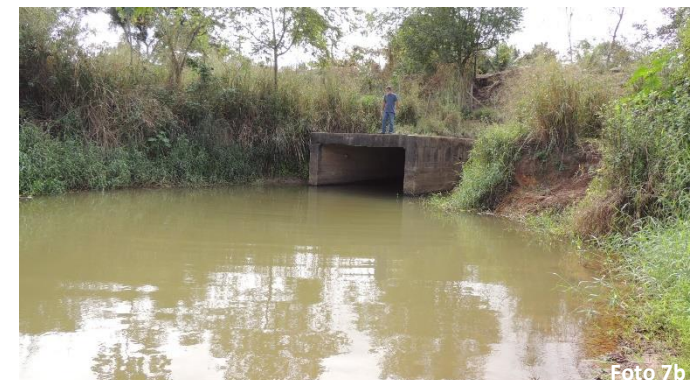
Parte da comporta para o canal Itereré, visivelmente obstruído por vegetação e assoreamento
