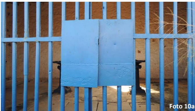
Entrada com cadeado na parte interior para evitar vandalismo. Pode ser observado na marcação em vermelho, vergalhões adicionados sobre o acesso interno da comporta.
