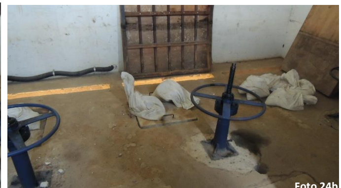
Parte interna da comporta com sacos de areia para dificultar o acesso pela parte inferior da comporta
