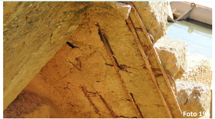
Estrutura de acesso e pontos com ferragens expostas
