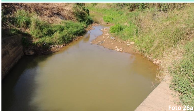
Trecho inicial do canal com assoreamento
