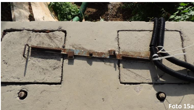
Estrutura da de acesso para parte interna da comporta e antiga estrutura de bombeamento
