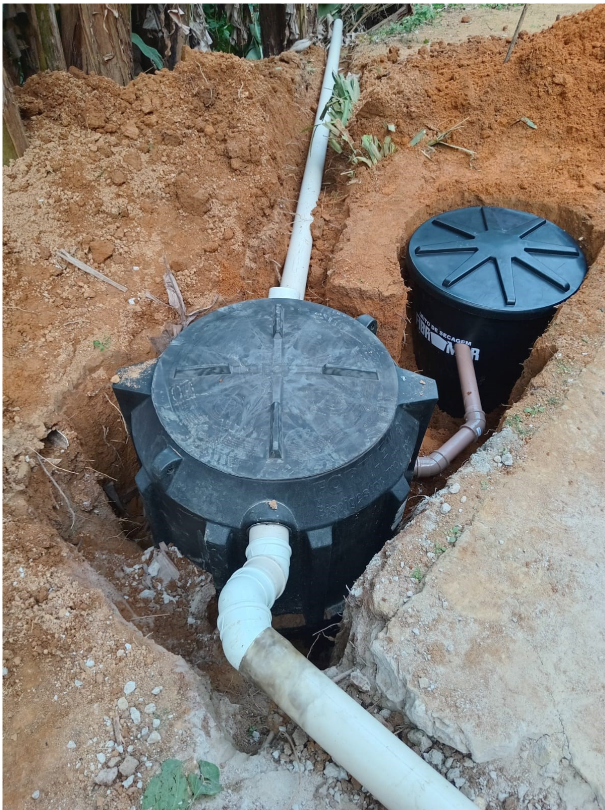
Foto 10 - Biodigestores instalados na localidade de Praia Vermelha, na Ilha Grande em Angra dos Reis/RJ. Projeto contratado com recursos do FUNDRIH.
