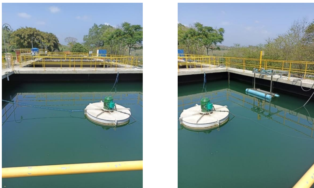
Figura 7 – Imagens do 4º Tanque concluído na ETE Bandeira Branca - Jacareí, em outubro de 2022.
