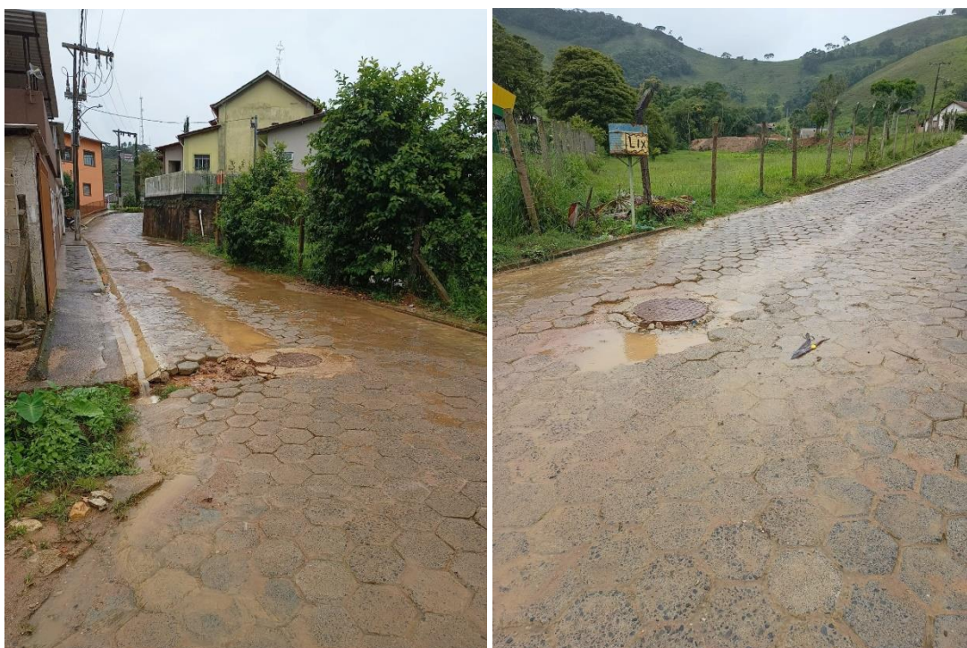
Figura 12 – Fotos do avanço da implantação do Sistema de esgotamento sanitário de Olaria/MG, em dezembro de 2022.
