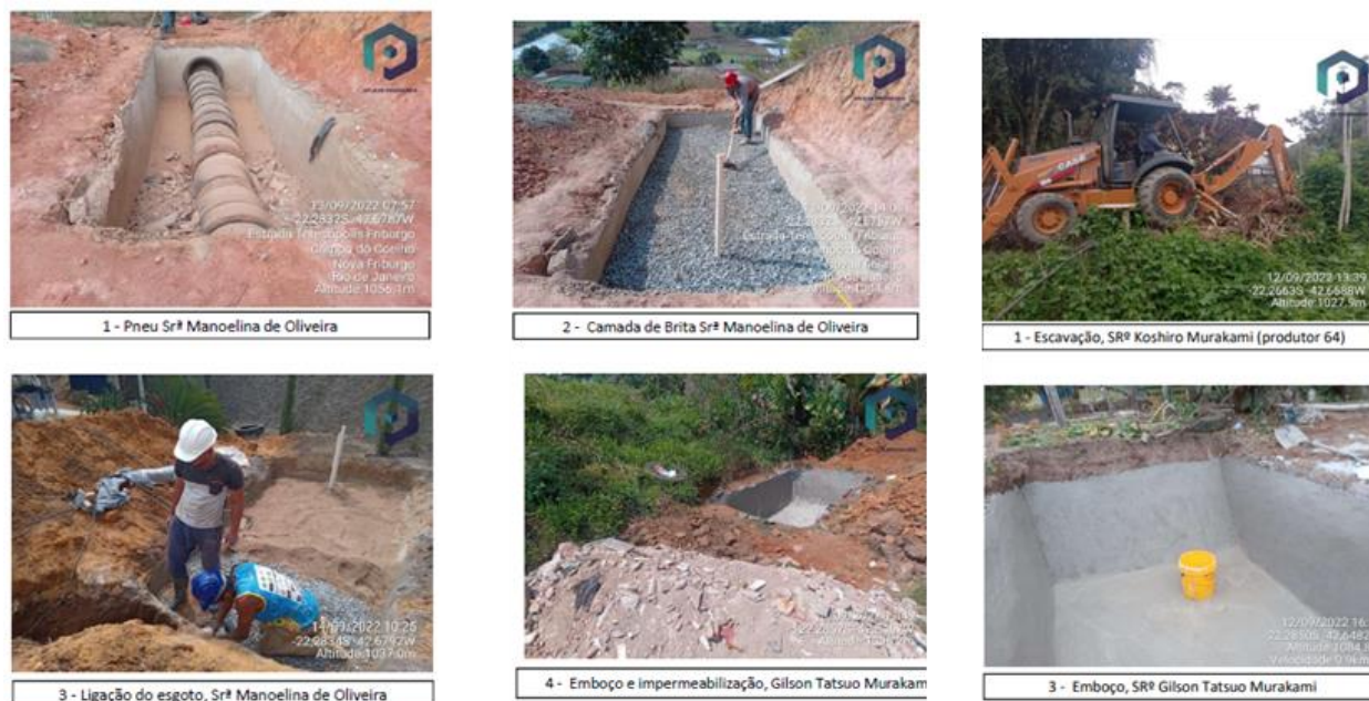
Figura 15 – Obras de instalação de sistemas de tratamento de efluentes domésticos na microbacia de Barracão dos Mendes em Nova Friburgo/RJ.
