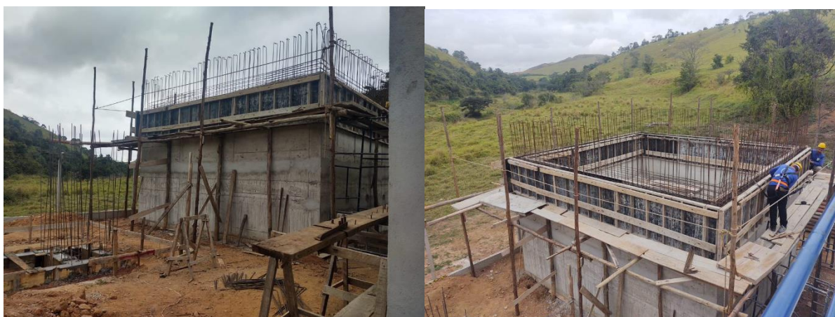
Figura 9 – Avanço das obras na ETE Areias em junho de 2022.
