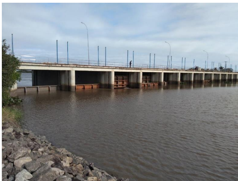
Figura 4 – Visita Técnica à Comporta de Campos dos Goytacazes
