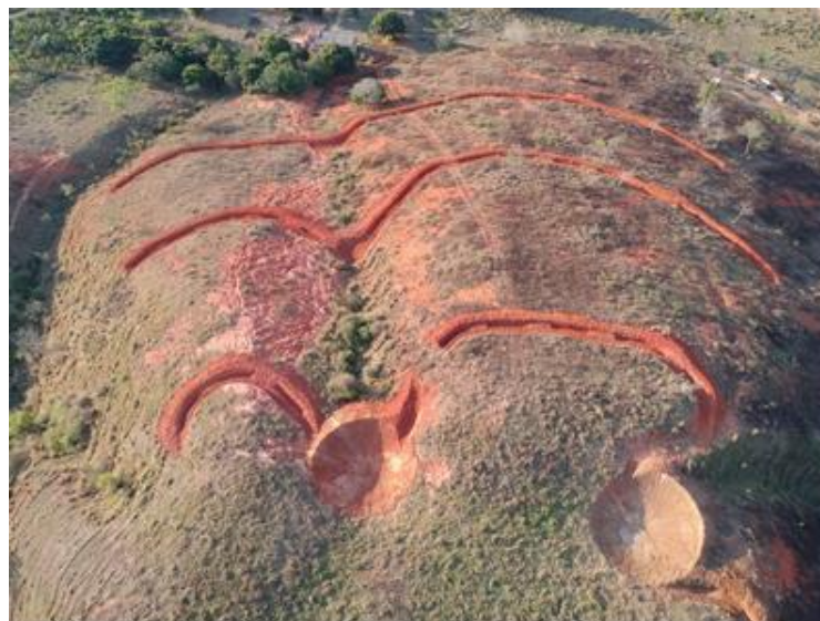
Figura 13 – Terraços perpendiculares à drenagem do terreno e integrados às bacias de retenção em área levemente declivosa
