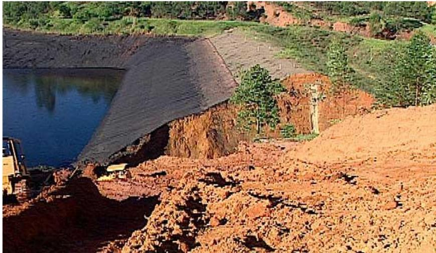
**Figura 7.3.3** – Rompimento da barragem de lixívia, em Cataguases, em 29 de março de 2003
