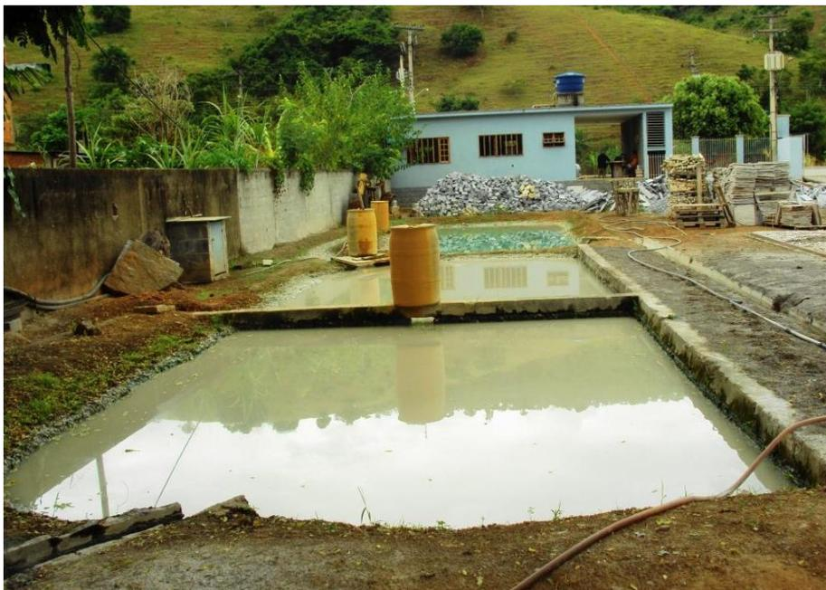
**Figura 7.2.3.1** - Tanques de decantação que viabilizam o recolhimento dos rejeitos e o reaproveitamento da água na Serraria Comércio de Pedras Paraíso (Fonte: Silvestre *et al* 2012).
