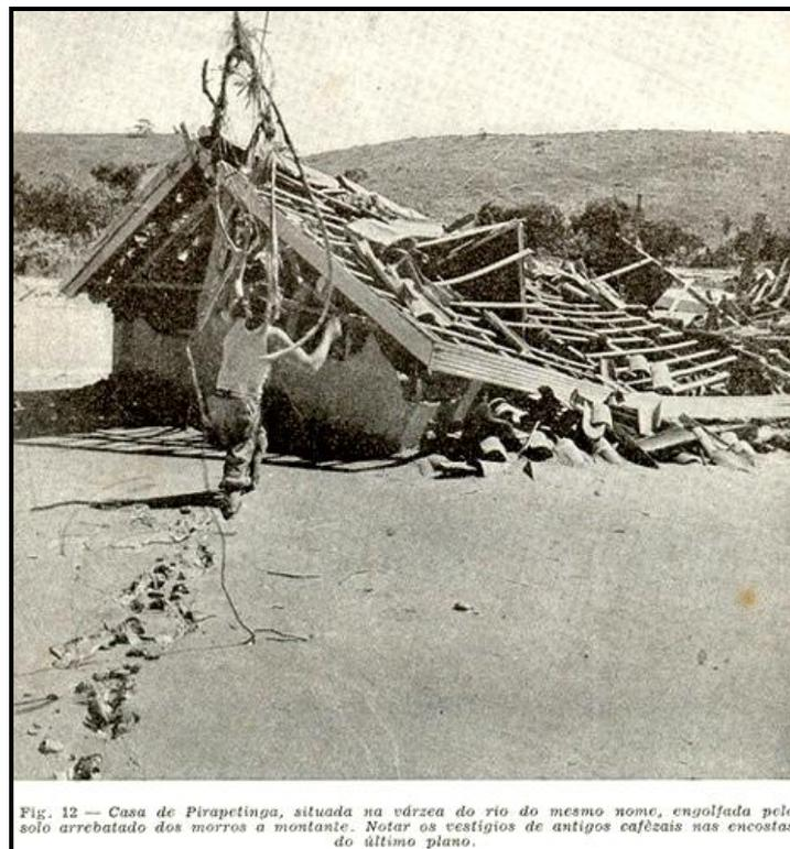
**Figura 3.3.1.2** - Registro de soterramento ocorrido em 1948 na várzea do rio Pirapetinga, bacia do Rio Paraíba do Sul, MG/RJ (Sternberg, 1949).
